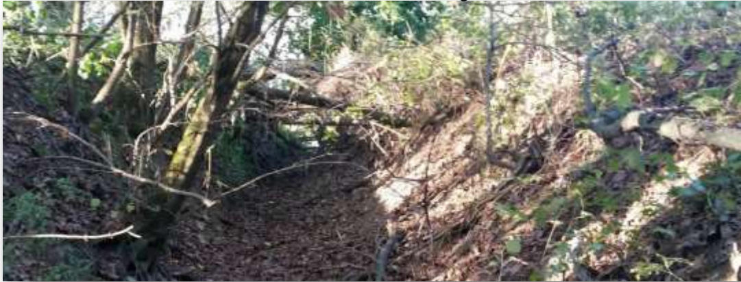
Canale a valle della chiavica in direzione del Fiume Oglio
